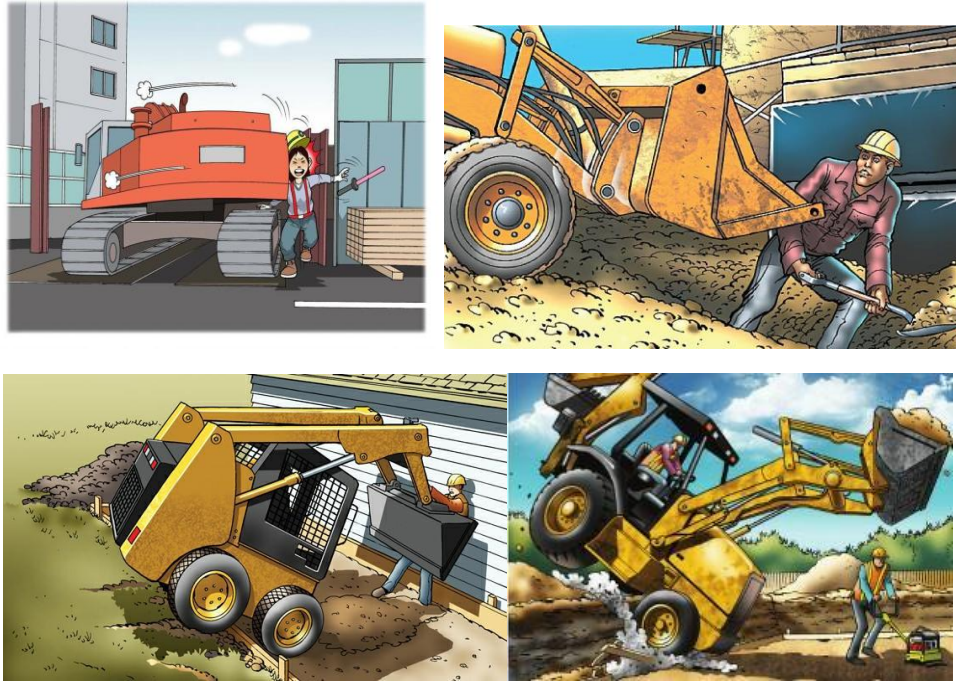
Fig. 3 Greseli in desfasurarea de lucrari in apropierea utilajelor [3]
