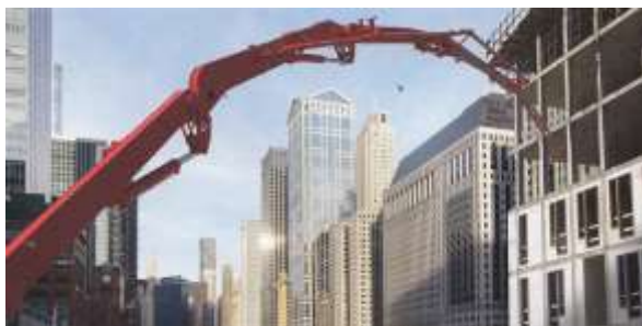
Fig.1,a și b. Brațul desfășurat al pompei de beton (a) cu furtunul de capăt (b).
