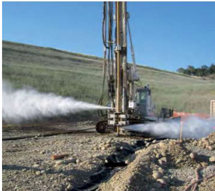
Fig.3 Exemplu de instalație de jet-grouting [5]
