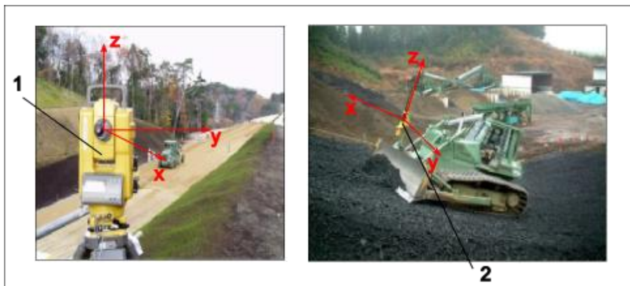
Figura 1 – Automatizarea procesului de săpare cu buldozerul
